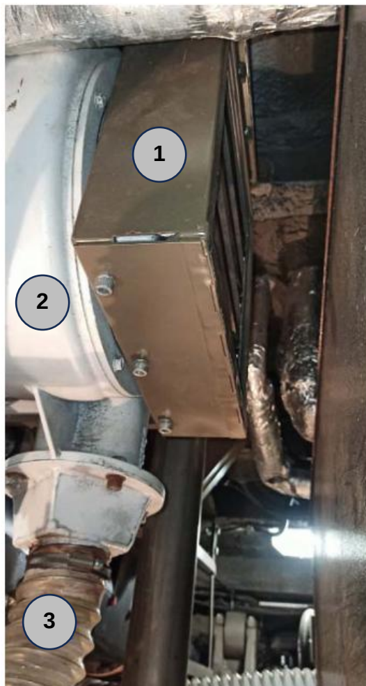
1 – Filter, 2 – Ventilátor, 3 - vzduchové potrubie
